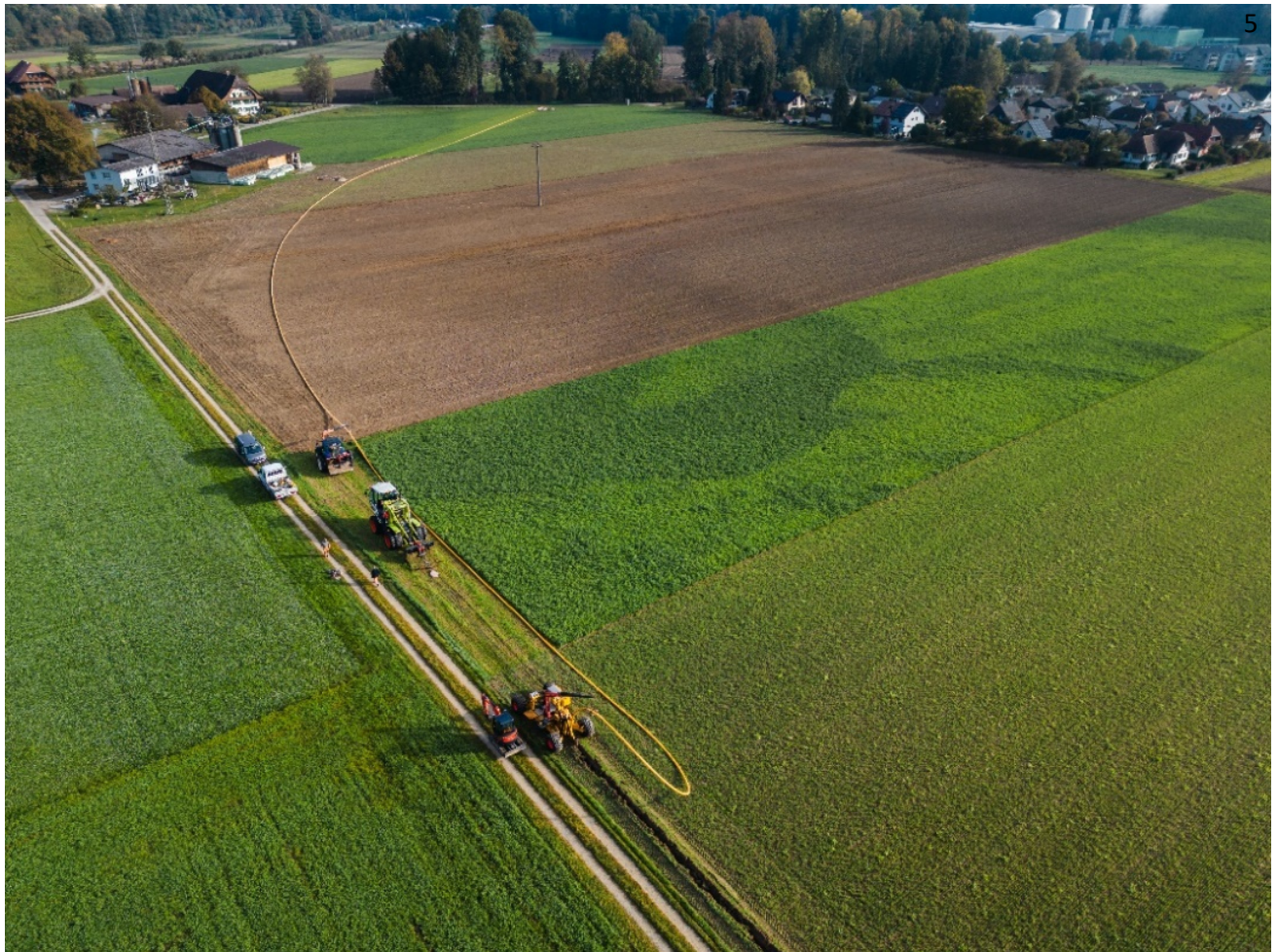
Bild 5: Luftaufnahme der Leitungsbauarbeiten Quelle: Regio Energie Solothurn
