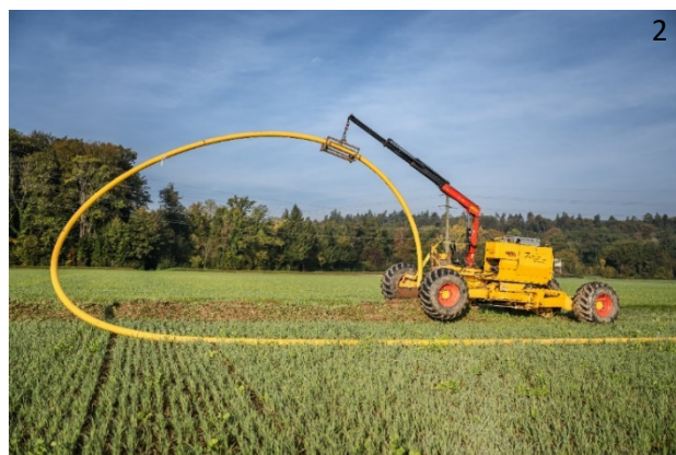
Bild 2: Einpflügen und direktes Einlegen des PE-Rohres GEROfit® Quelle: Regio Energie Solothurn
