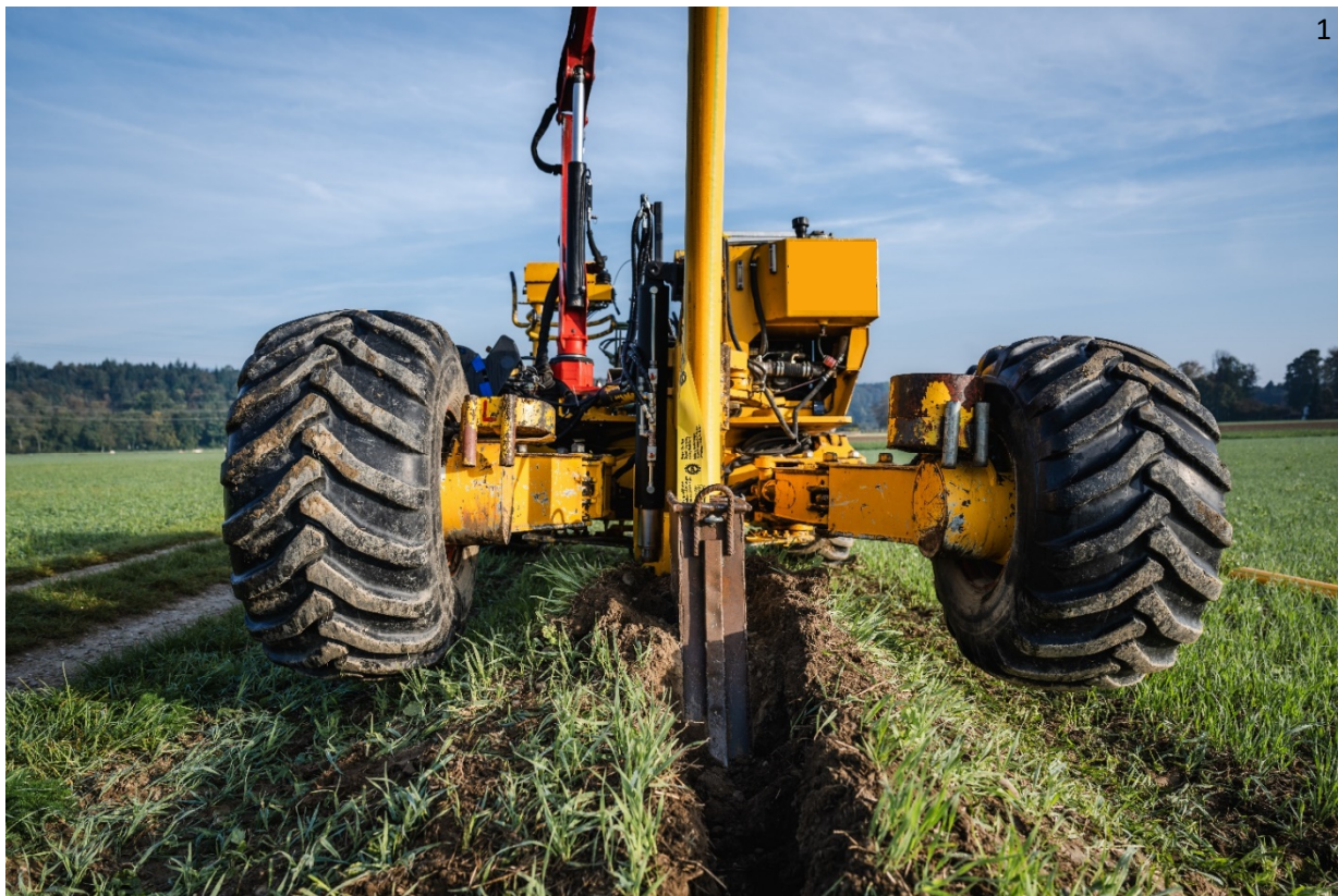
Bild 1: Einpflügen mit Kabelpflug KPZ 160 durch Grabenlos AG Quelle: Regio Energie Solothurn
