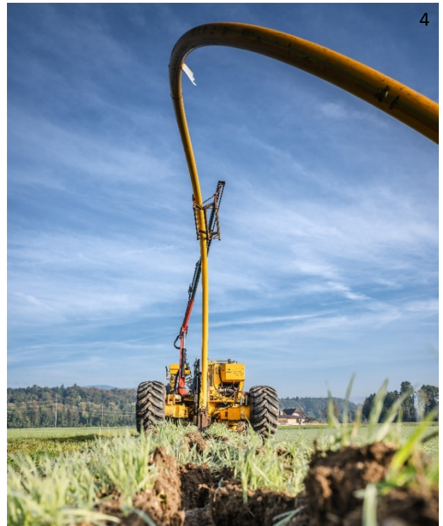
Bild 4: Einpflügen des vorgeschweissten PE-Rohres GEROfit® Quelle: Regio Energie Solothurn
